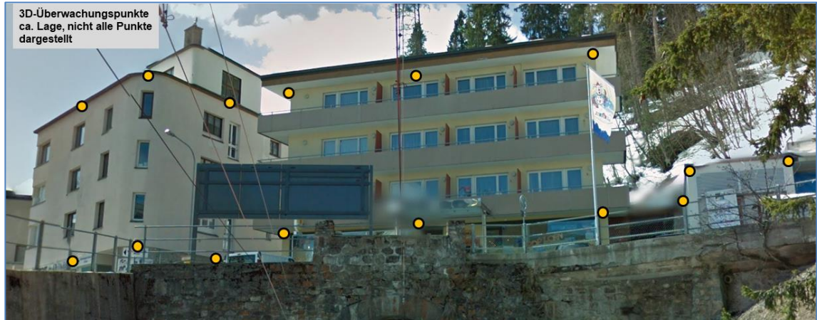
Abb. 7 Anordnung der Messpunkte (nicht alle Punkte sichtbar, vergl. Abb. 5)
